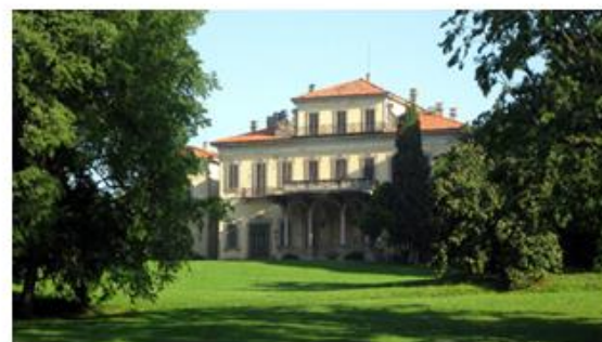
Arcore: Villa Borromeo d'Adda (cantiere per il restauro conservativo)
